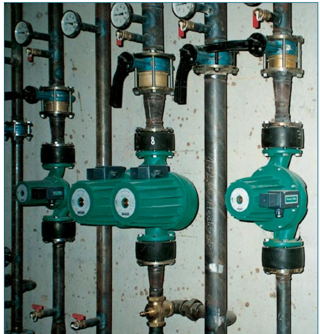
Příklad montáže tlumiče hluku a vyřací
